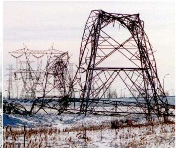
Összerogyott légvezeték tartó oszlopok
