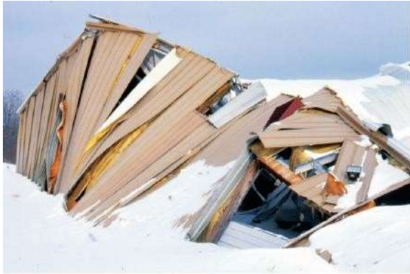
Könnyűszerkezetes építmény összerogyása hóteherből
