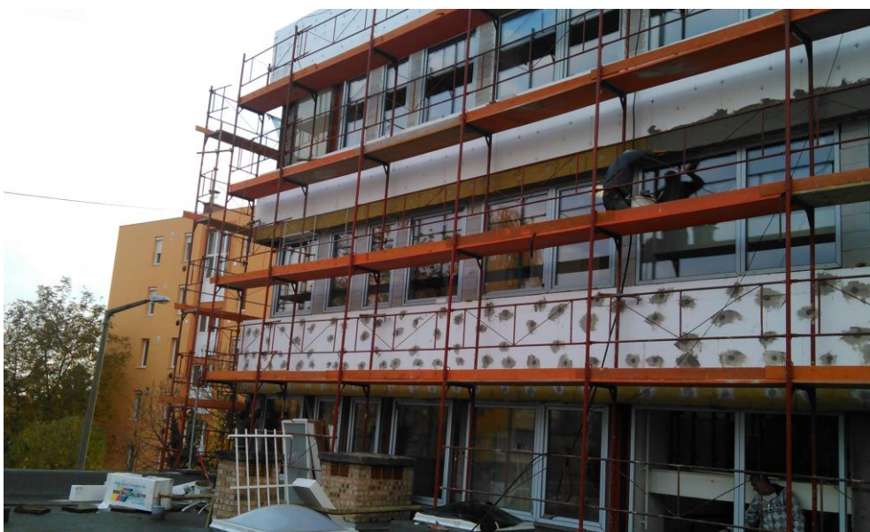
KEOP Hajdúnánás felújítás közben
