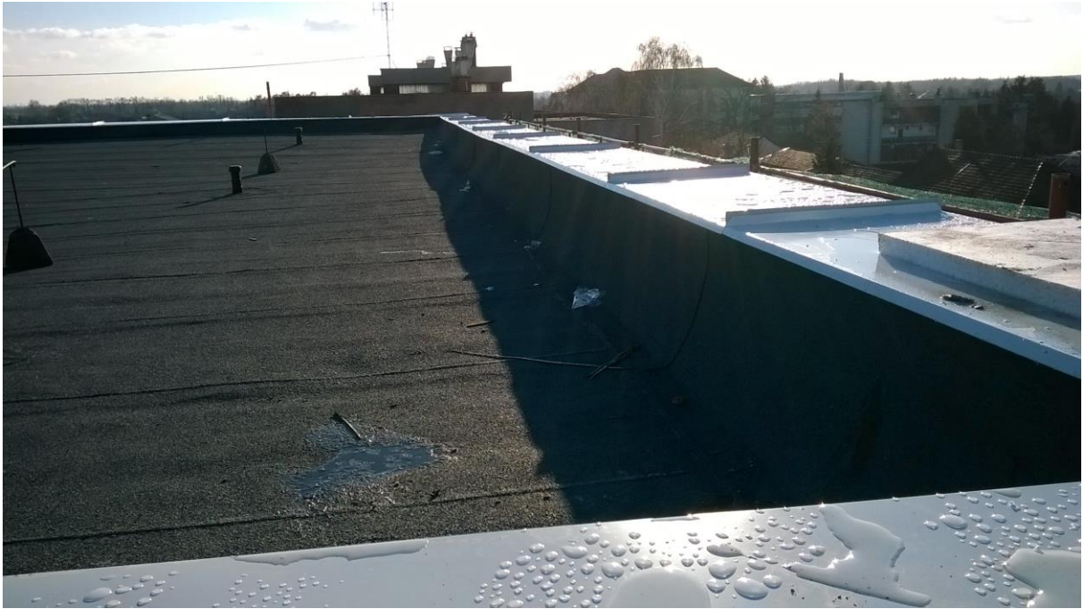
KEOP Hajdúnánás tetőfelújítás
