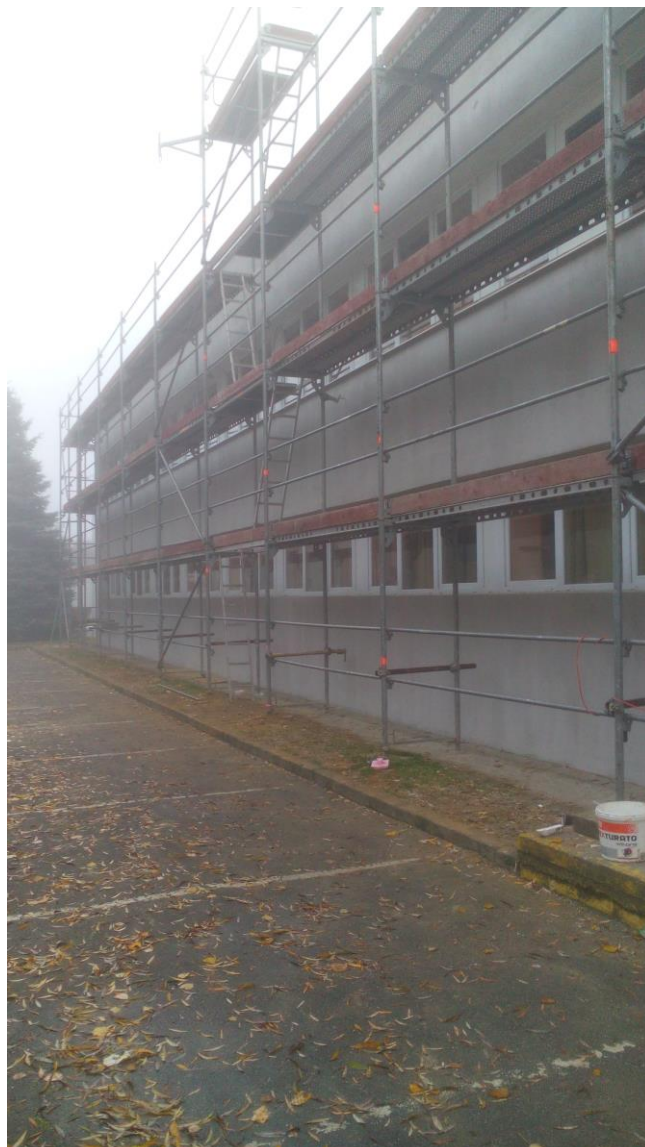
KEOP Bartók Béla úti épület felújítás közben
