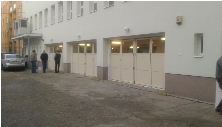
KEOP Piac u. garázkapuk felújítás után
