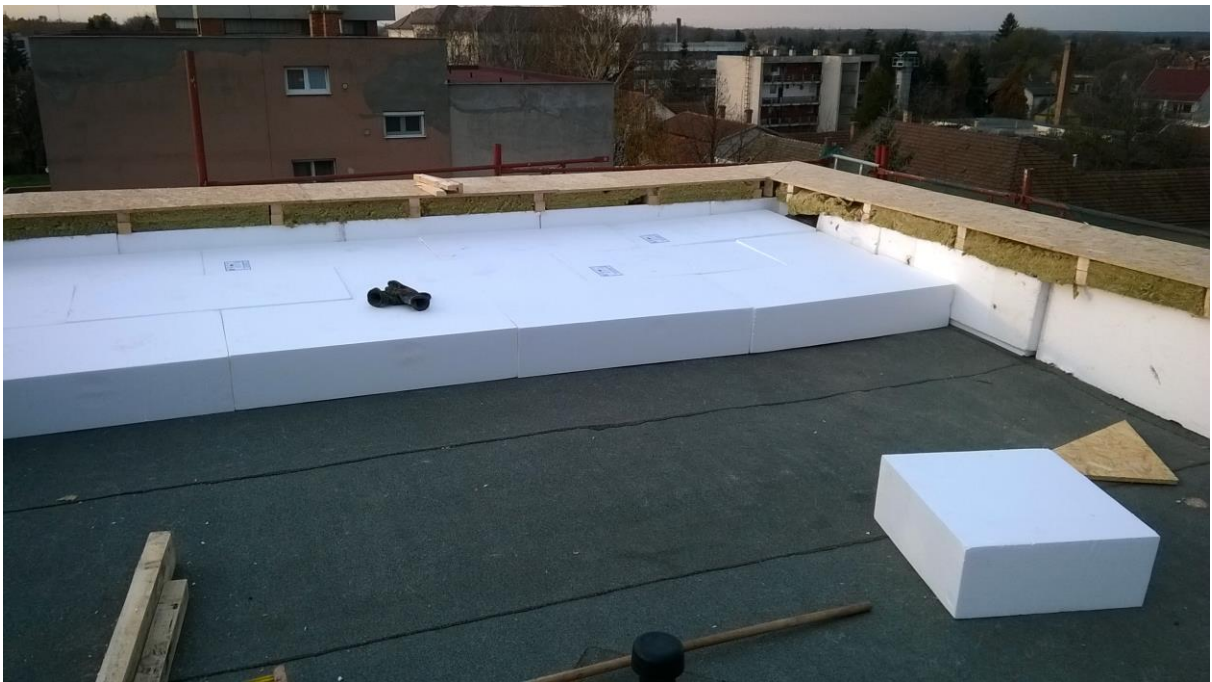
KEOP Hajdúnánás tetőszigetelés közben
