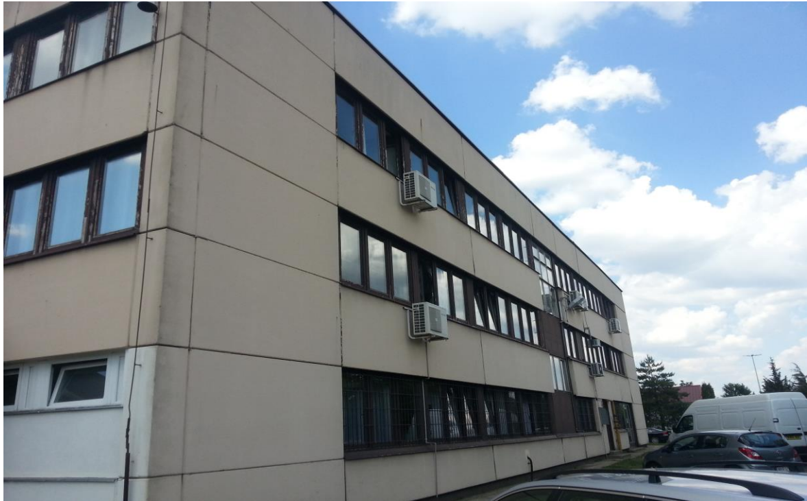
KEOP Bartók Béla úti épület felújítás előtt
