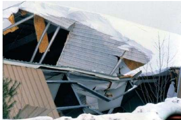
Könnyszerkezetes építmény összerogyása hóteherből
