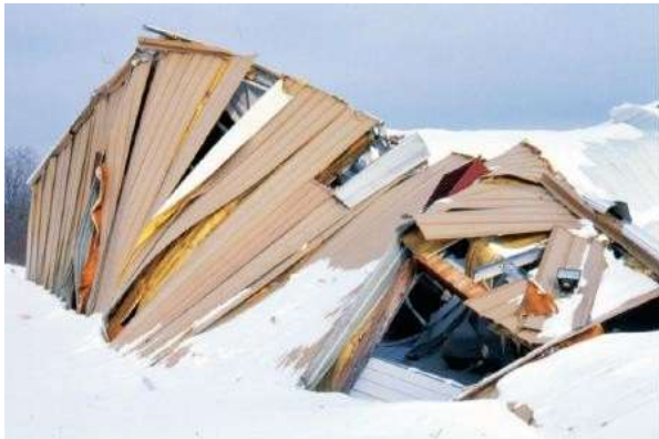
Könnyszerkezetes építmény összerogyása hóteherből
