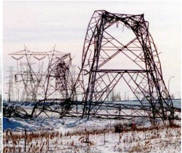
Összerogyott légvezeték tartó oszlopok
