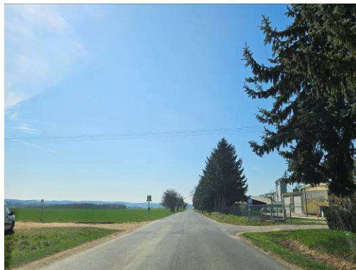
0193 hrsz út útcsatlakozása a 7383 j. ök. útra
