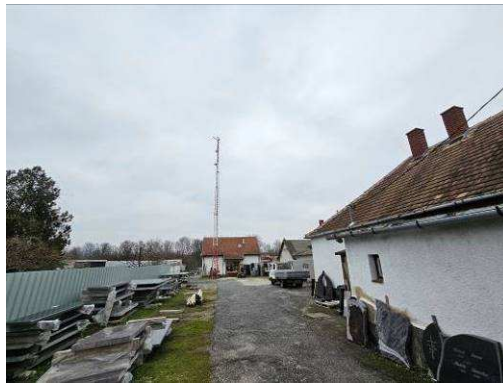
A Rákóczi Ferenc utca 29. házszaám, 16 hrsz alatti adótorony látképe (2024. december)
