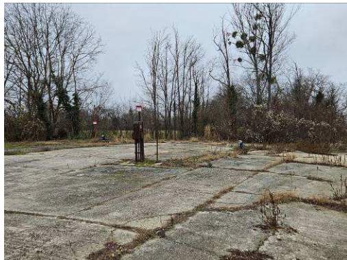
A 2018-as településrendezési eszköz módosítás során kijelölt közműterület fényképe (2024. december)
