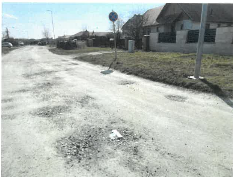
7. számú fényképfelvétel Síp u. 11. szám előtti közútszakasz - Szilárd anyagmintavétel (útfeltöltési közúzalék)
