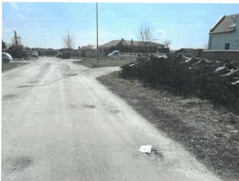
6. számú fényképfelvétel Síp u. 73. szám előtti útszakasz - Szilárd anyagmintavétel (útfeltöltési közúzalék)
