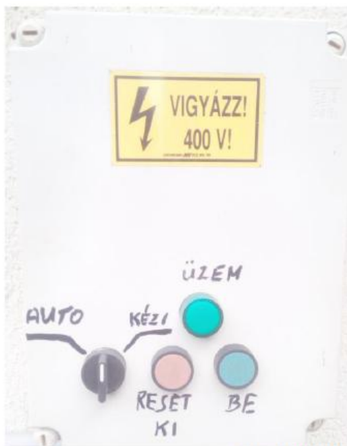
3. ábra Biofilter villamos kapcsolószekrény
