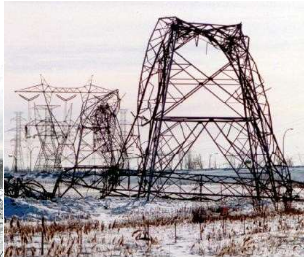
Összerogyott légvezeték tartó oszlopok
