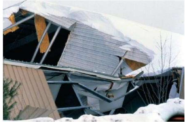
Könnyűszerkezetes építmény összerogyása hóteherből
