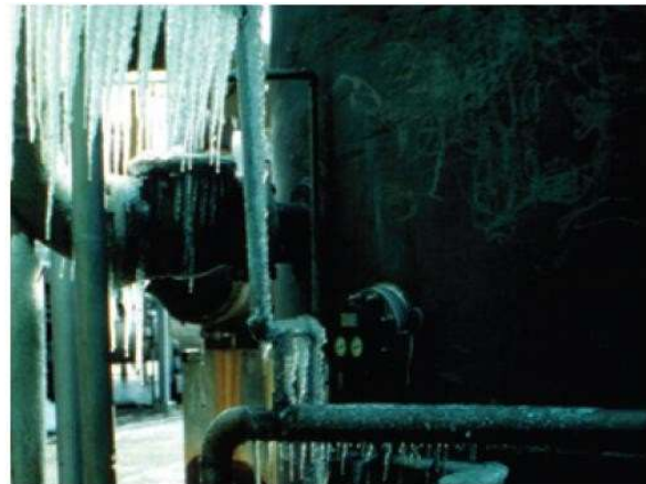
Egy éjszakára nyitva hagyott ajtó miatt elfagyott vízvezeték lyukadásának következménye
