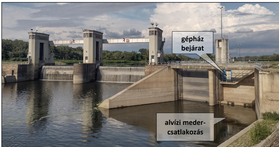
12. ábra Alvízi medercsatlakozás
