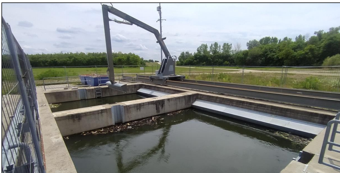
7. ábra Átmeneti műtárgy az automata gerebtisztítóval (háttérben a hulladékgyűjtő konténerek)
