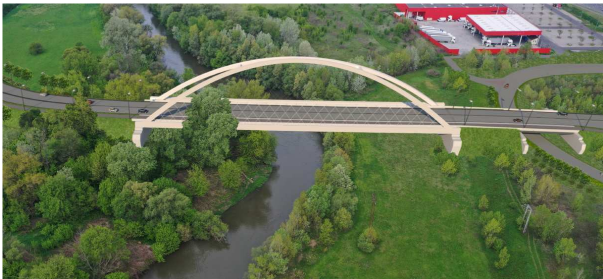
8. ábra B4 jelzetű híd Sajó feletti híd
