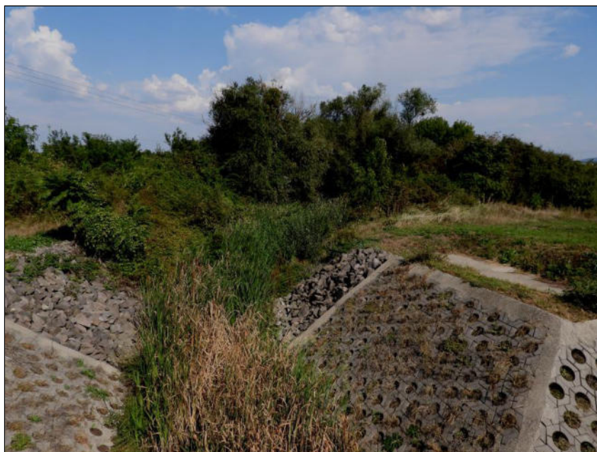
2. kép: A Május-patak befolyója és a Bodrog-folyó gátjának zsilipháza közötti rész benőtt medre
