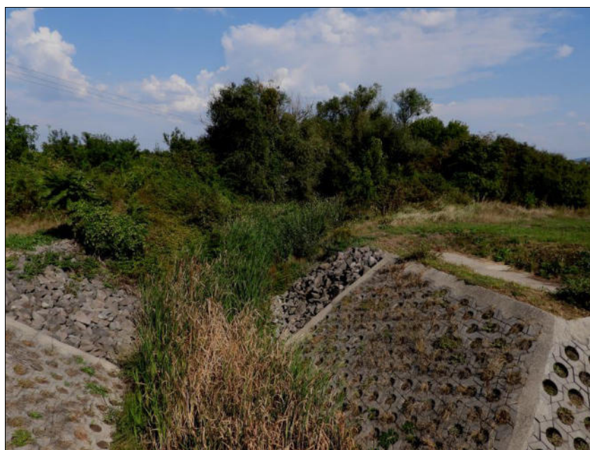
2. kép: A Május-patak befolyója és a Bodrog-folyó gátjának zsilipháza közötti rész benőtt medre
