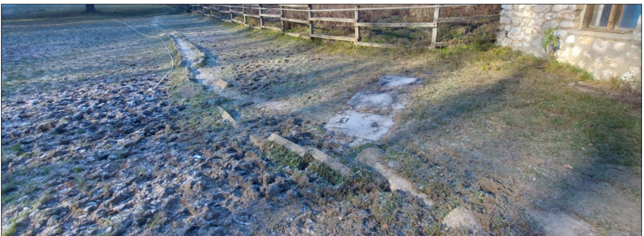
3. számú kép: A telep létesítésekor készített kibetonozott sekély vízlevezető árok romjai.
