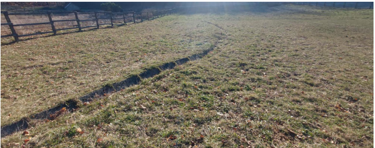
2. számú kép: Az ismeretlen időben készített, az areális eróziótól védő kibetonozott sekély vízlevezető árok a kerítéstől a kijelölt puffer területen át félkörívet írt le a vízműházig. Ez a vízlevezető csatorna az évek során betemetődött, az évek során tönkrement, tisztítása és javítása nem történt meg.
