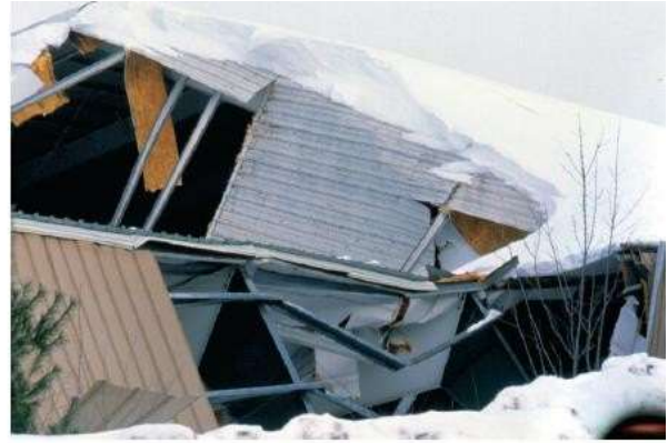
Könnyűszerkezetes építmény összerogyása hóteherből
