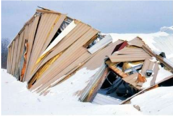
Könnyűszerkezetes építmény összerogyása hóteherből
