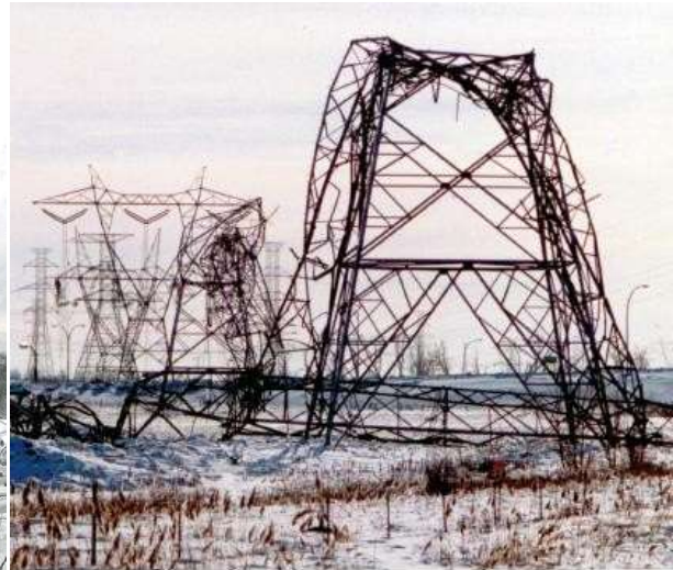
Összerogyott légvezeték tartó oszlopok
