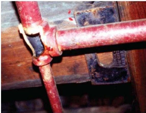
Egy éjszakára nyitva hagyott ajtó miatt elfagyott vízvezeték lyukadásának következménye
