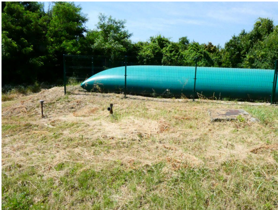
5. ábra: Felszíni tűzivíz tároló tartály és előtte a földalatti szennyvíztároló építményei
