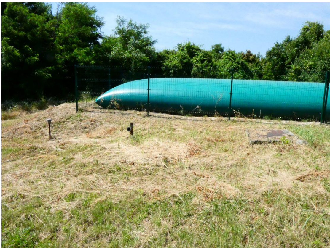
2. ábra: Felszíni tűzivíz tároló tartály és előtte a földalatti szennyvíztároló építményei
