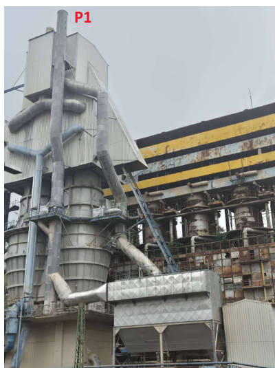
P1 pontforrás MAERZ kemence portalanító kürtő
