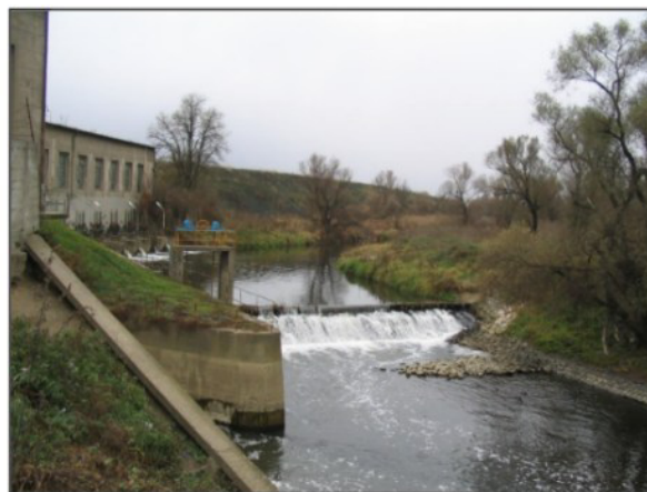
1-7. ábra: Kazincbarcika-Berente Hőerőmű üzemvízcsatorna fixgát és vízkivételi mű
