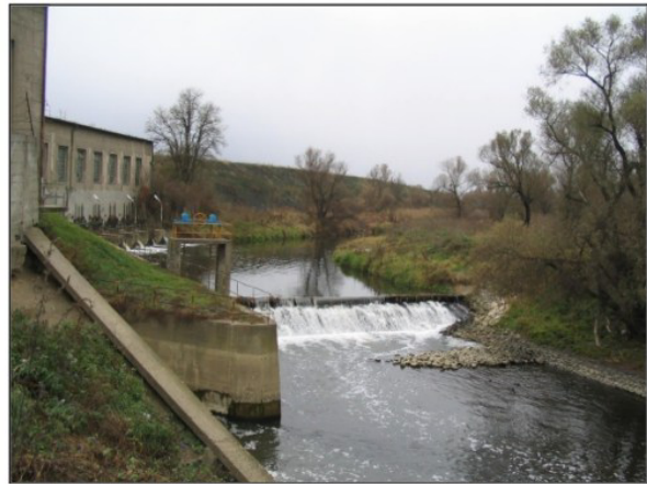
1-7. ábra: Kazincbarcika-Berente Hőerőmű üzemvízcsatorna fixgát és vízkivételi mű
