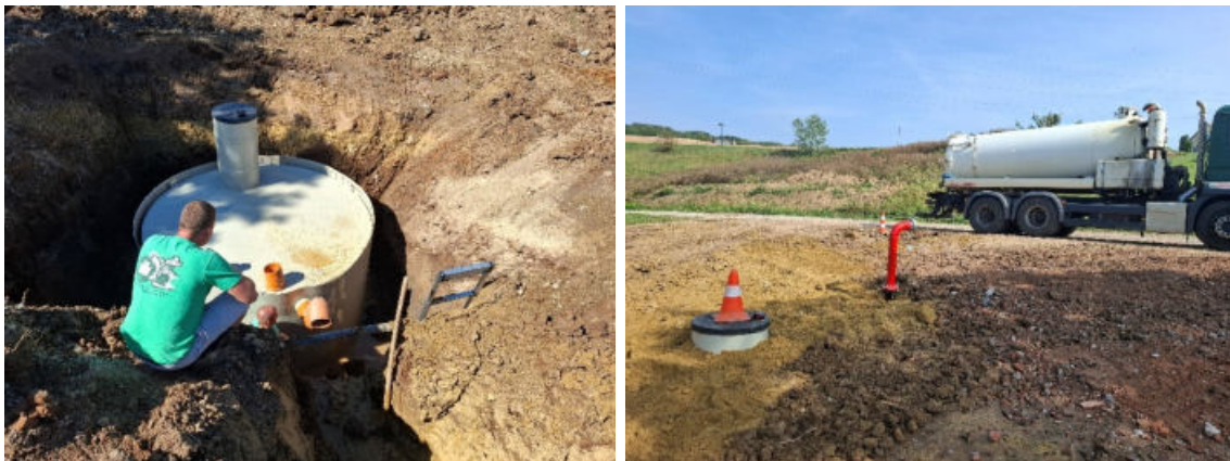
4. kép: Az új Sz-5 jelű szennyvíztartály (2024. augusztus)
