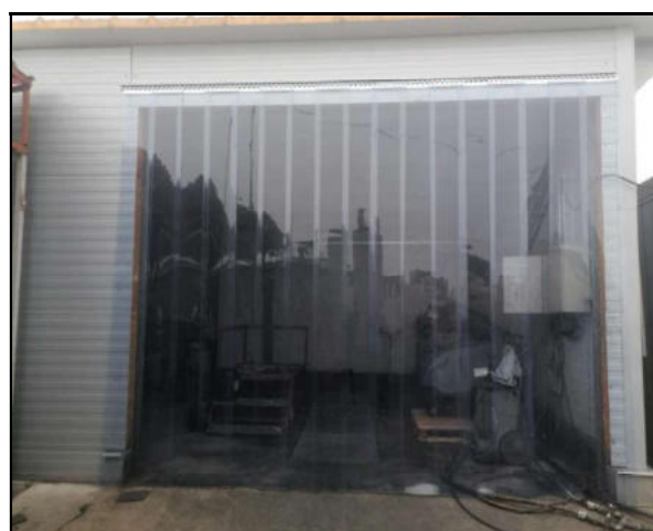
6. sz. kép: Tartálymosás helye (átalakítás után, szalagfüggönnyel)
