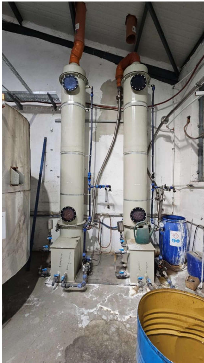
23. kép 2 db gázmosó (pontforrás)
