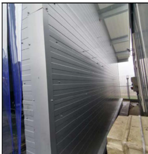
9.-10. sz. kép: A zárttá tett mosóhelyiség szendvicsszerkezetű oldal- és tetőpanelje
