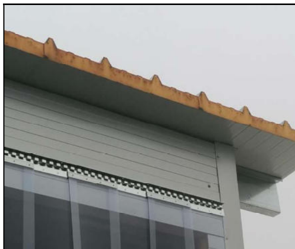
9.-10. sz. kép: A zárttá tett mosóhelyiség szendvicsszerkezetű oldal- és tetőpanelje
