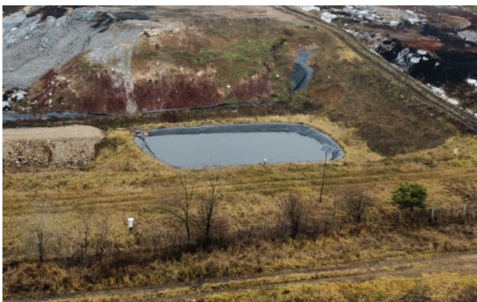
13. kép: A Határ-völgyi III. ütemhez kialakított csurgalékvíz-gyűjtő medence (2025. január)
