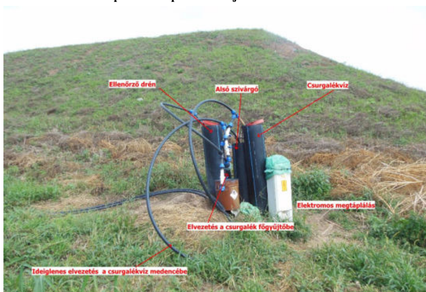
5. kép: A II. depónia kivezetései az átalakítás után
