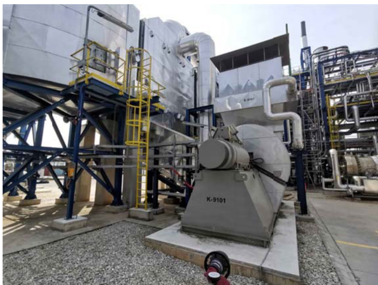
6. kép Az SMR kemence (reaktor) égéslevegő ventilátora (K-9101), és az egyik előmelegítő hőcserélő (E-9107)
