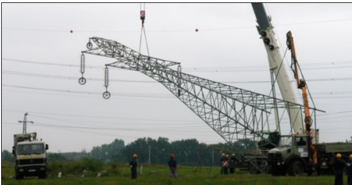
5. ábra Távvezeték oszlop állítása
