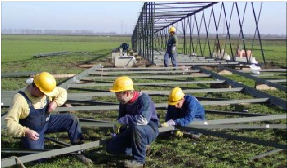
4. ábra Helyszíni oszlopszerelés
