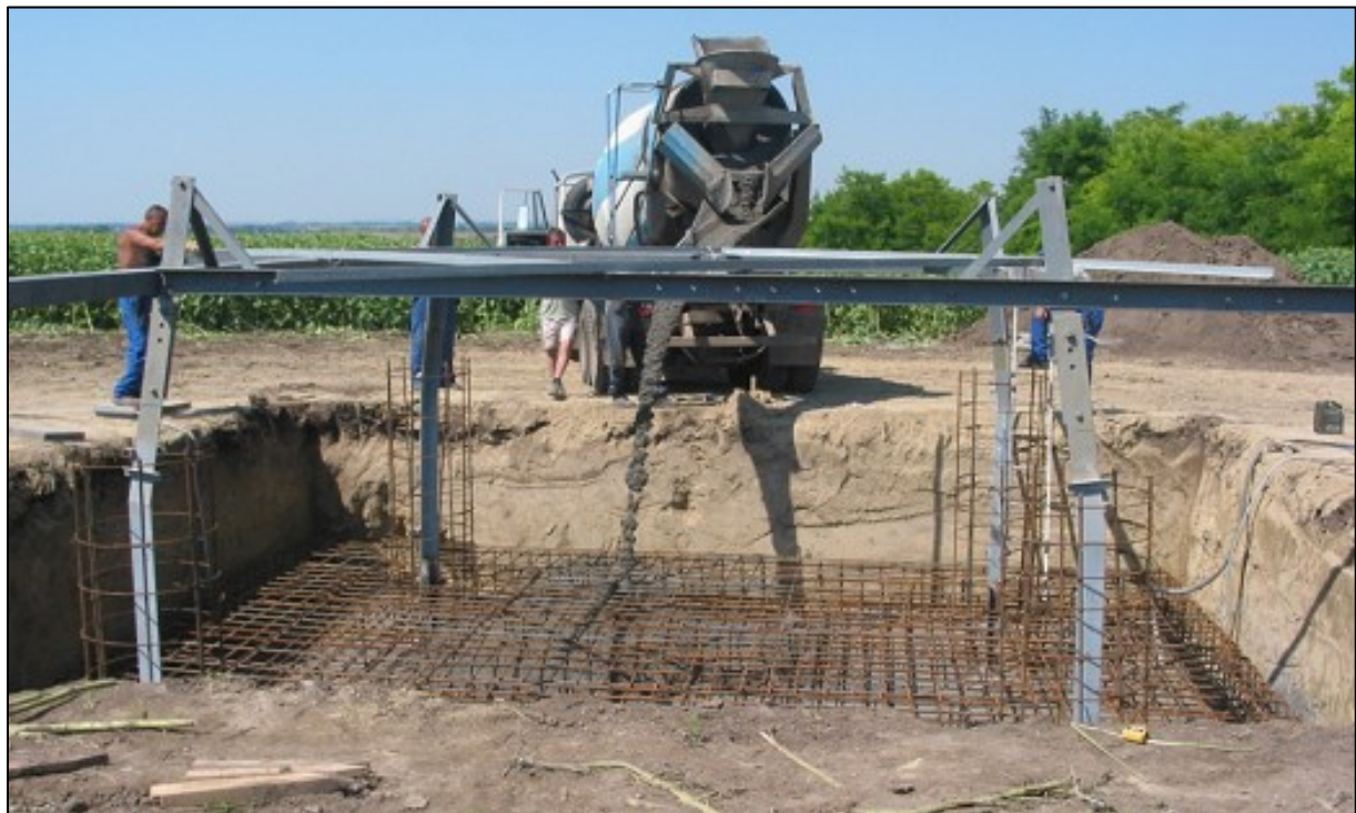
3. ábra Alapgödör betonozása
