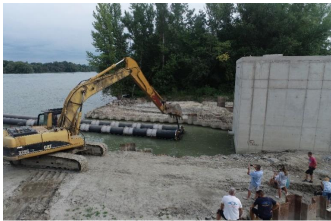
A szivóvezeték bekötése
