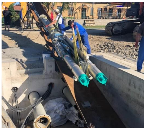
A merülőmotoros szivattyúk bevezetése a szerelvényaknába ...
