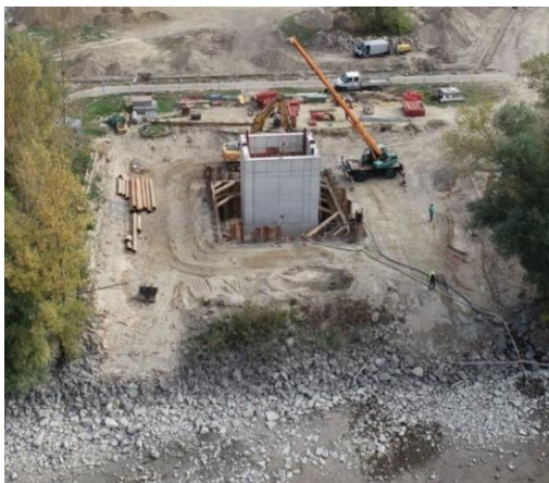
A vasbeton nedves akna építése a parton
