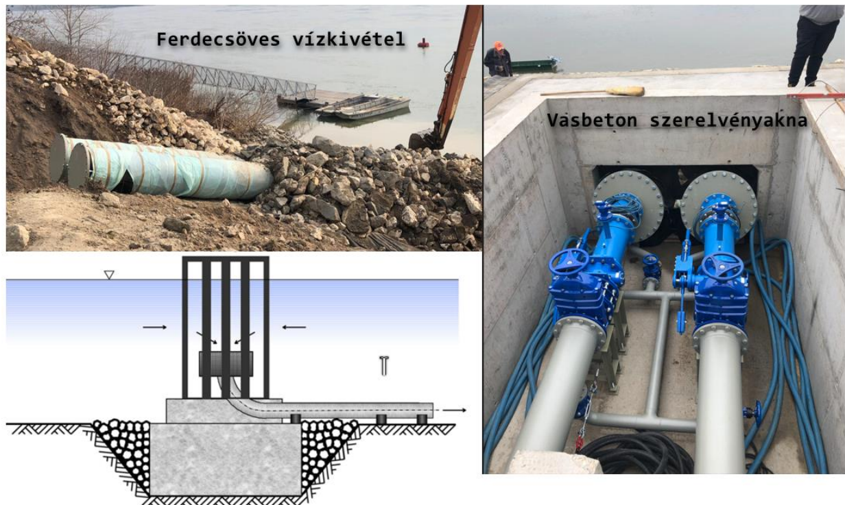
Folyómederbe telepített szívócsöves vízkivételi műtárgy
