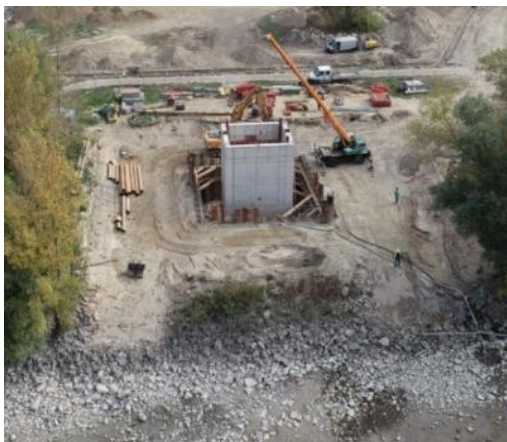
A vasbeton nedves akna építése a parton
