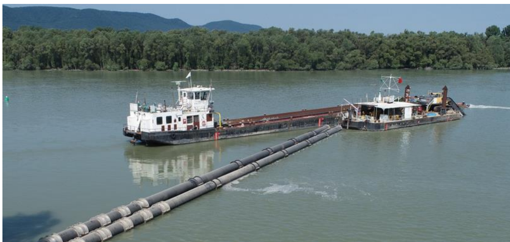
Szívóvezeték bevontatása a főmederbe (egy korábbi hasonló vízkivételi mű építésénél)
