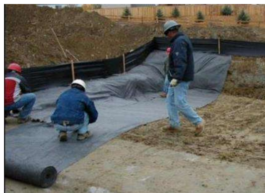
Beton lemosóhely kialakítása
