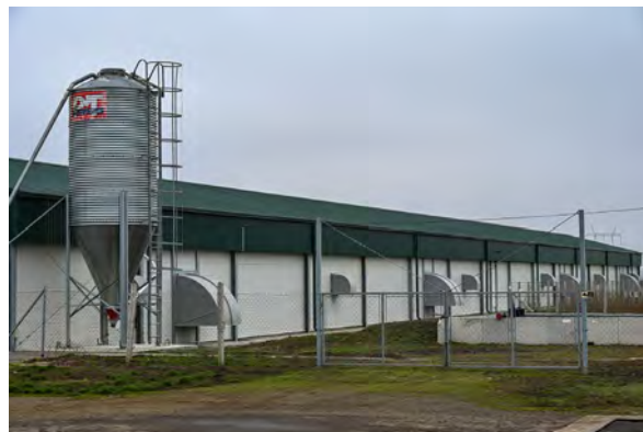
Az ólak másik oldalán a kis és nagy teljesítményű ventilátorok vannak. Előtérben egy táptároló siló látható
