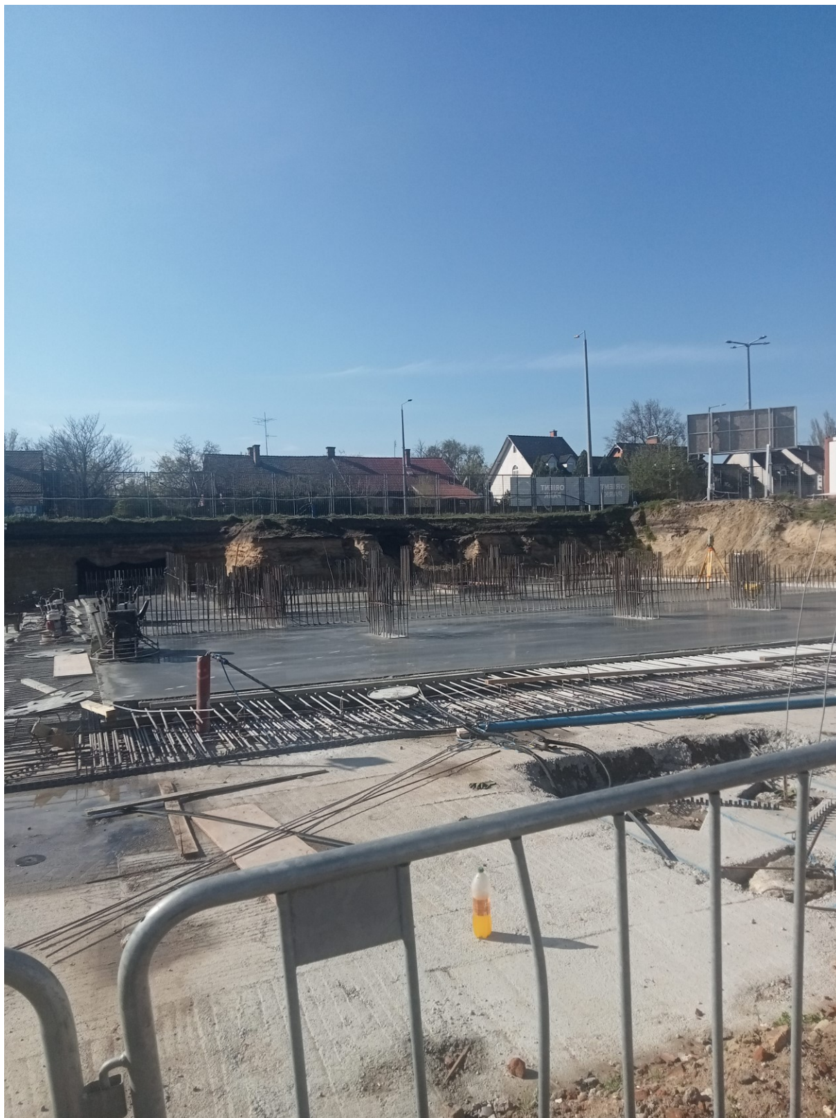
Az „A” toronyépület pinceszinti alaplemeze a felmenő szerkezetek vasalásával.
