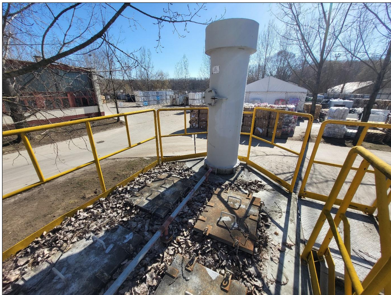
8. Ábra: P1 pontforrás, alatta az aktívszén szűrő tartálya
