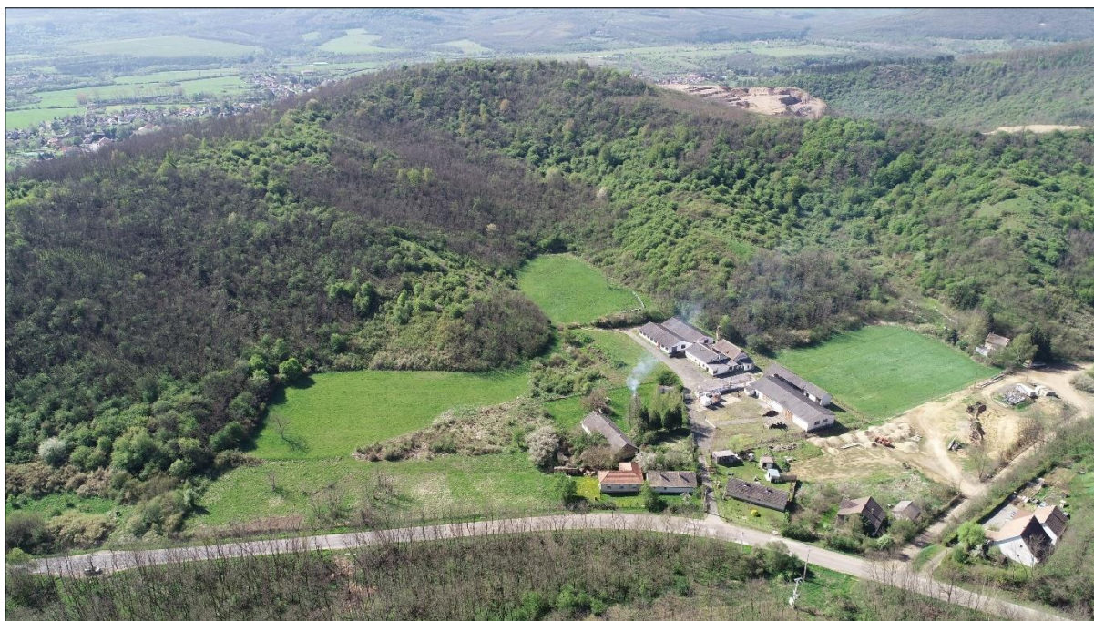
20. ábra: 2025.04.23. Háromhányás légifotója észak felől. A bánya telekhatárán kívül tervezett út láthatósága mindkét település (Recsk, Mátraderecske) felől erősen korlátozott. A tervezett szállítási útvonal a közút felől Háromhányás épületei miatt szinte teljes egészében takarásban van.
