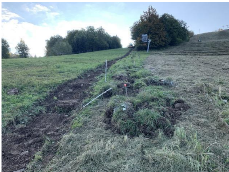
13. fénykép: Hóágyú vezeték csere gyep téglás módszerrel (2020 ősz)
