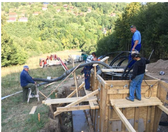
19. fénykép: A Panorámalift tartóoszlopainak építési munkái
