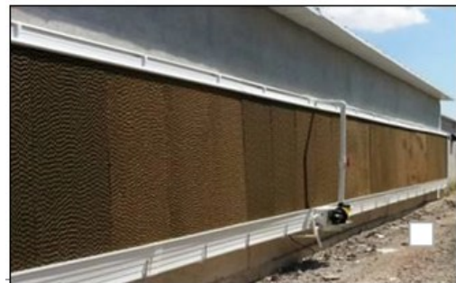
18. ábra: Hűtőpanel rendszer (forrás: Műszaki technológiai leírás)
