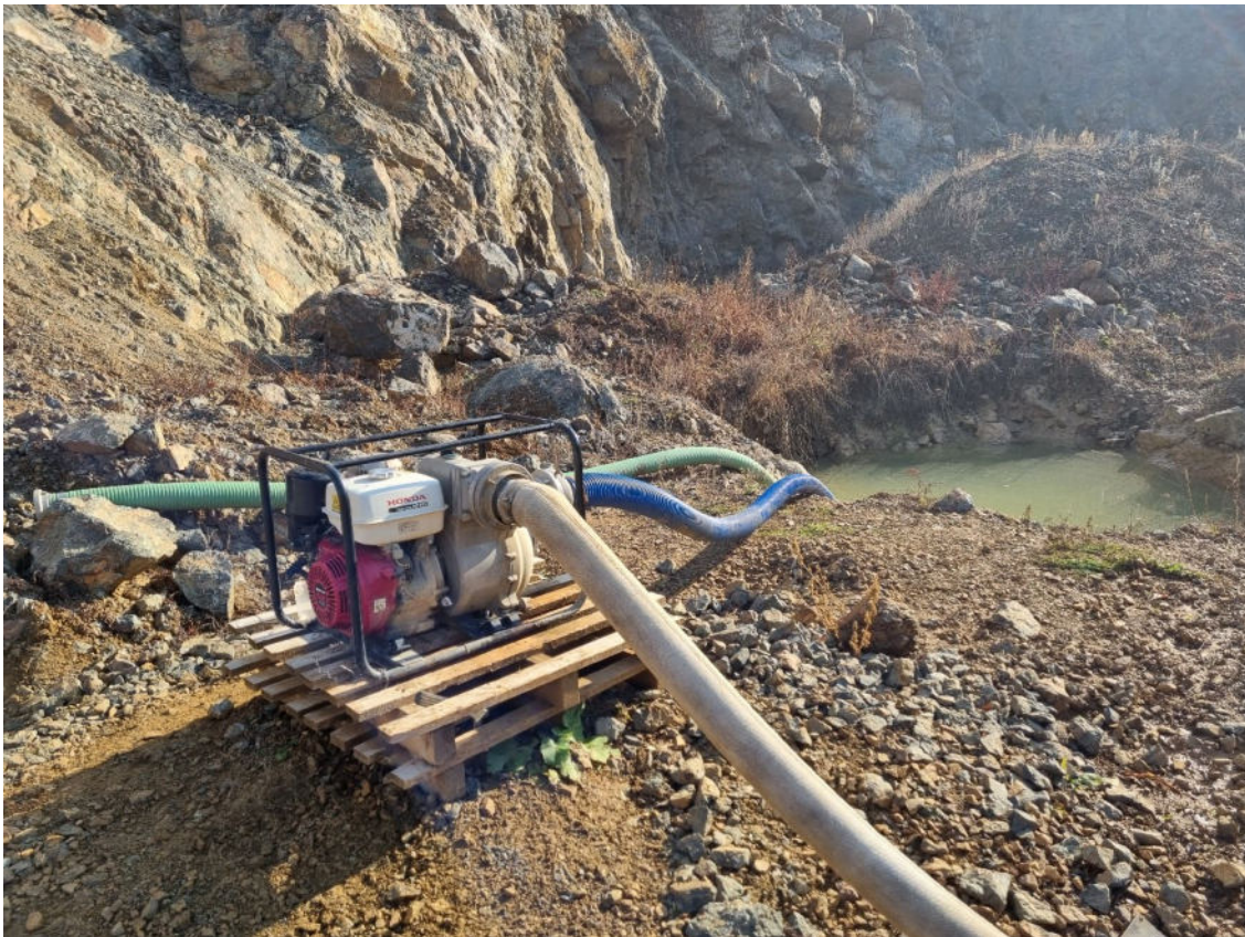
3. fotó: A víztelenítésre szolgáló zsomp a szivattyúval
