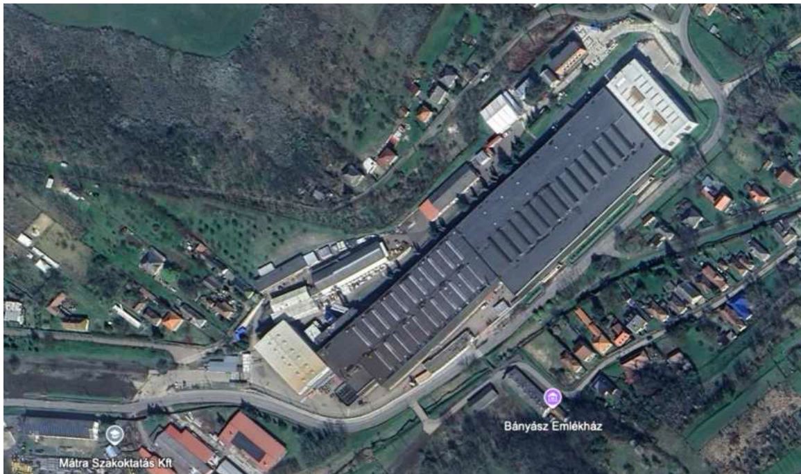
A telephelyen található létesítmények elhelyezkedése (forrás:Google earth)
