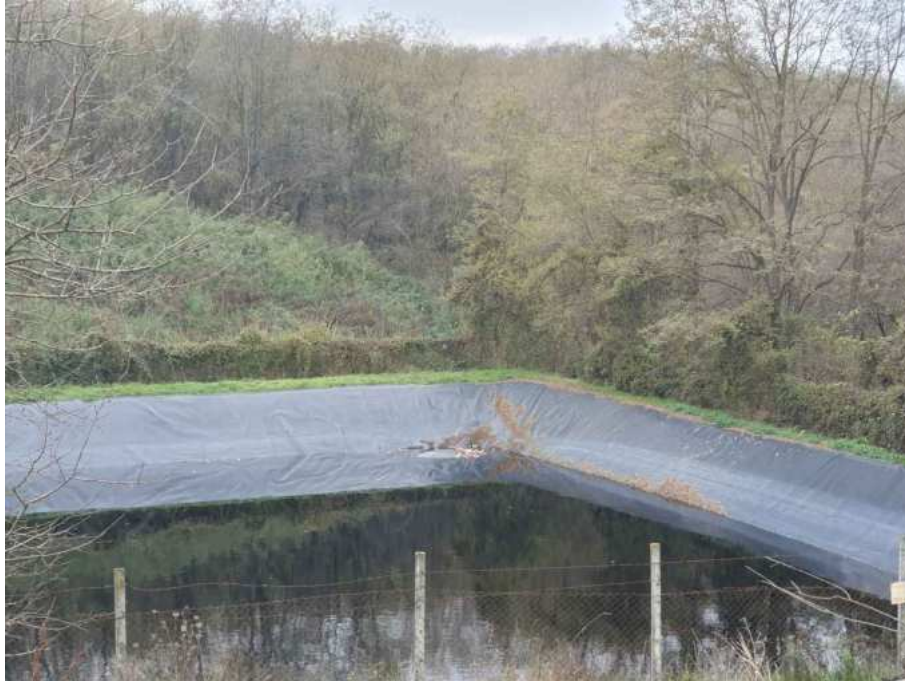
27. számú ábra: A lekerített csurgalékvíz medence
