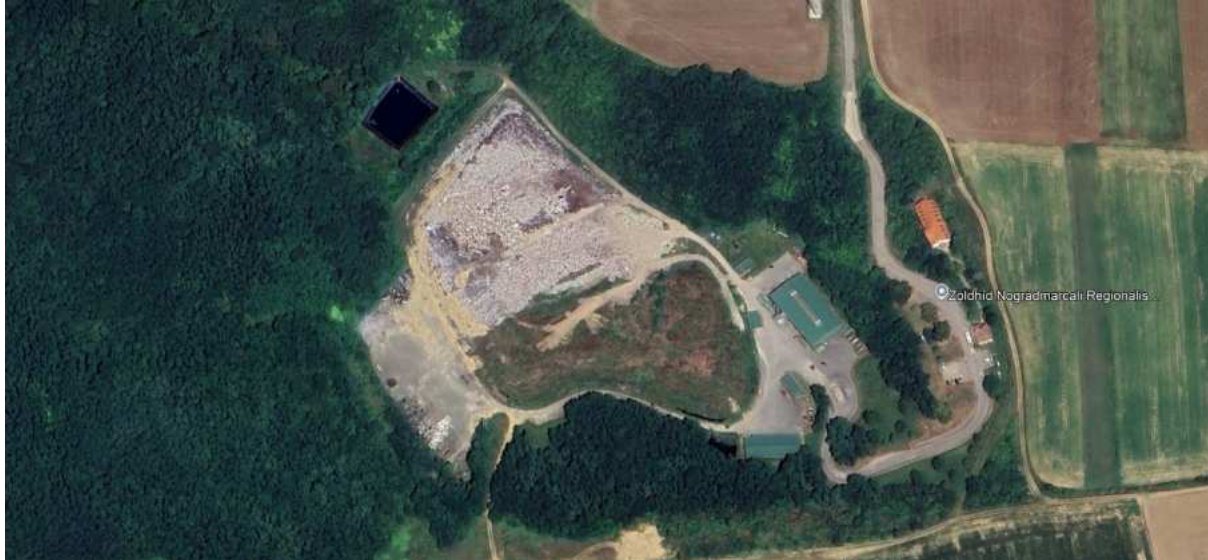
5. számú ábra: Hulladékkezelő és lerakó telep 2024.06.26-án (forrás: Google Earth Pro)
