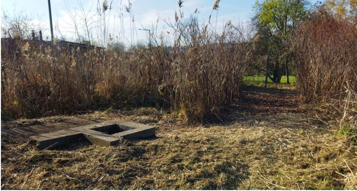
56. ábra: Vízkormányzási műtárgy a kibocsátási pont előtt
