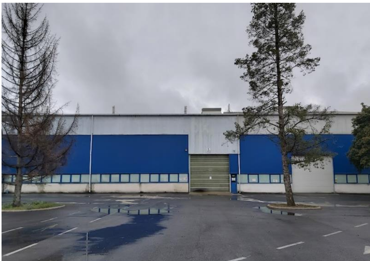
33. ábra: 2. számú homlokzat fénykép
