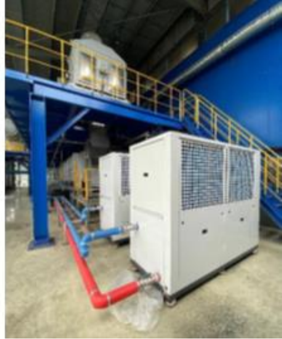
22. ábra: A forgó dobszárító hűtőegysége és a hozzá tartozó hőszivattyúk
