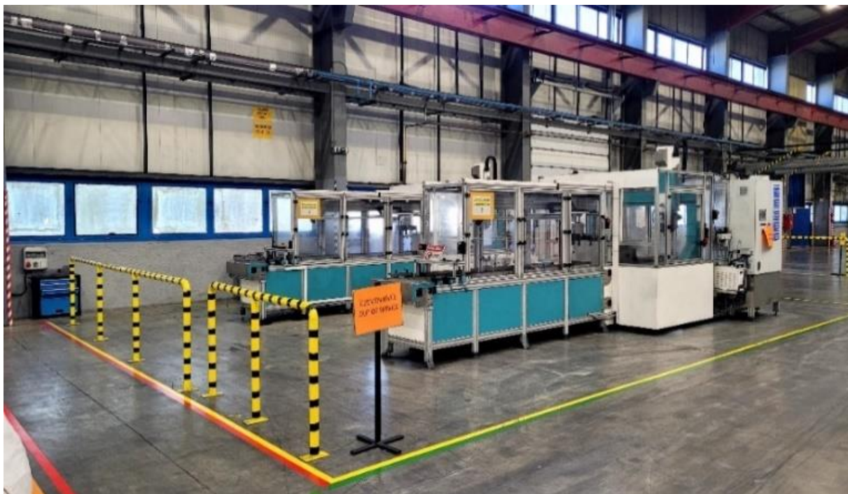
18. ábra: Modulvágó berendezések az üzemcsarnokon belül, korábbi helyükön
