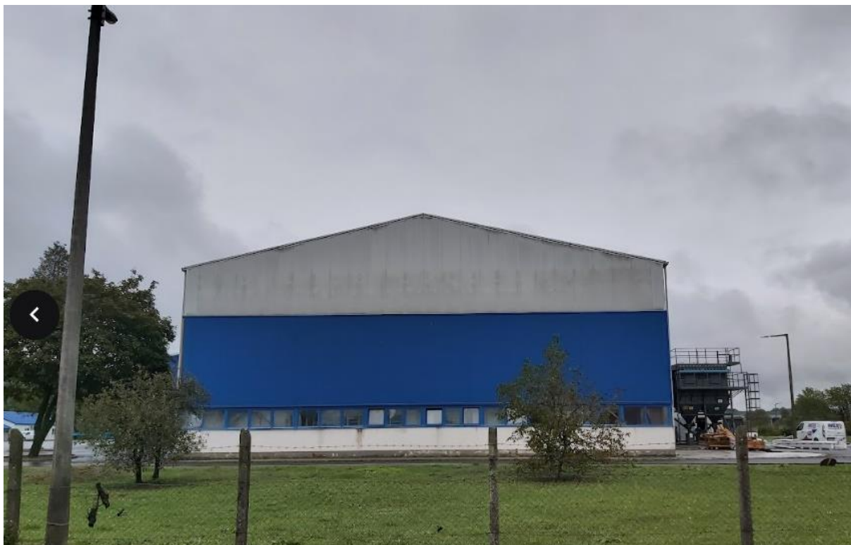
32. ábra: 1. számú homlokzat fénykép
