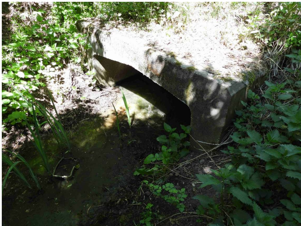
11-9. ábra: A tervezési területről a csapadékvíz bevezetési pont. A kép felső részén látható a csapadék és tisztított szennyvíz beömlő nyílás (kivezetési pont). A felvétel a vasúti töltésről készült.
