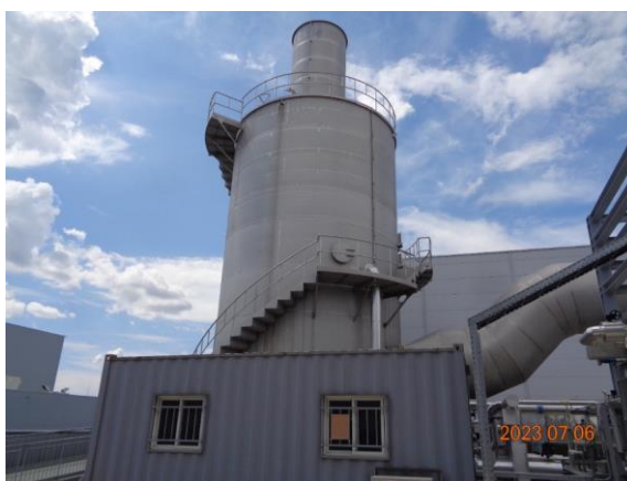
I. főépület 92 m tetején lévő gázmosó oldószer visszanyerő (P95)
