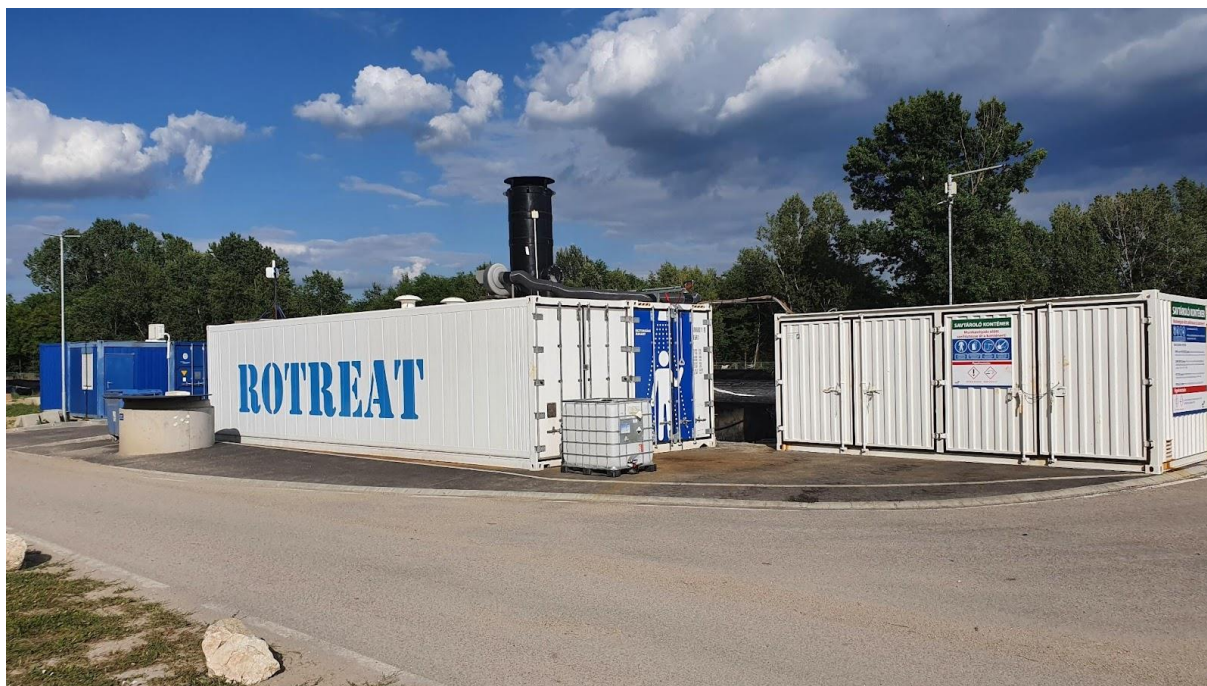
3-1. ábra: Üzemi tartózkodó és iroda konténerek (balra), RO és TaSy konténerek (középen), Savtároló konténer (jobbra)
