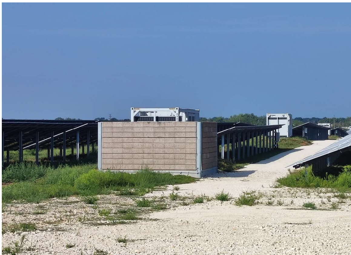
5. ábra: A megépült zajvédő fal az Inárcs, 084/59 hrsz-ú ingatlanon
