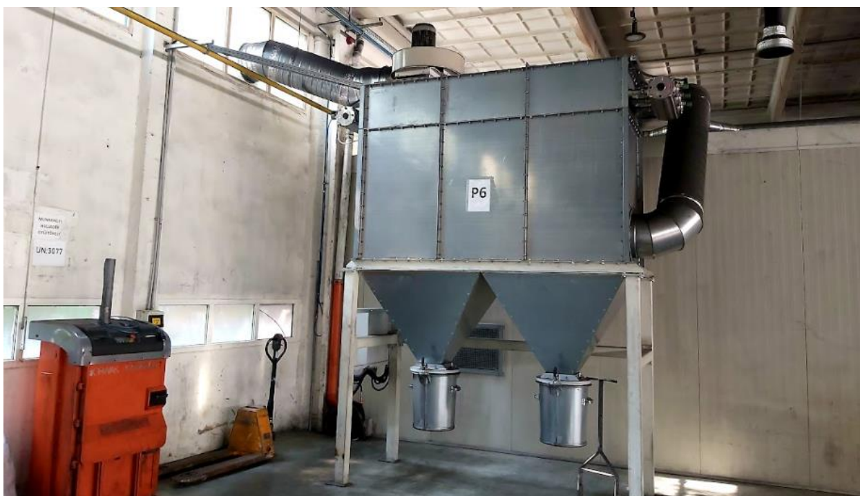
13. ábra: A bontóhelyiséghez kapcsolódó elszívó-berendezés szűrőegysége
