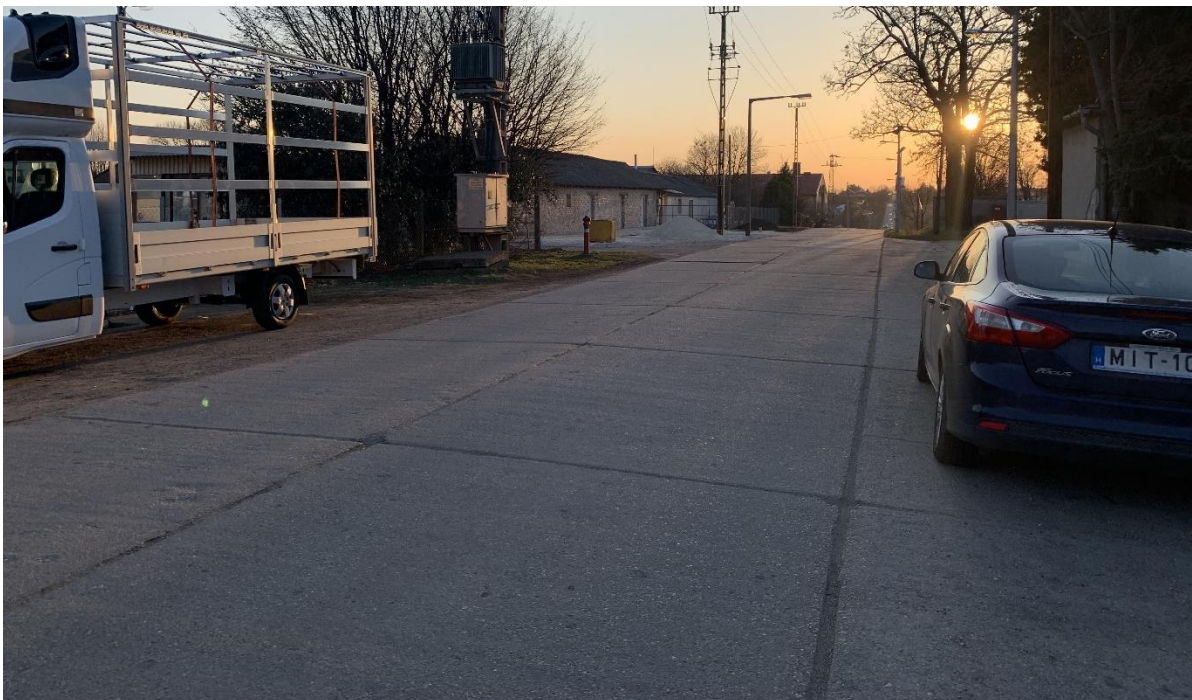
33. ábra: Zsámbéki út keresztmetszeti kialakítása, beton tábla burkolatú szakasz az I. és II. ütem között
