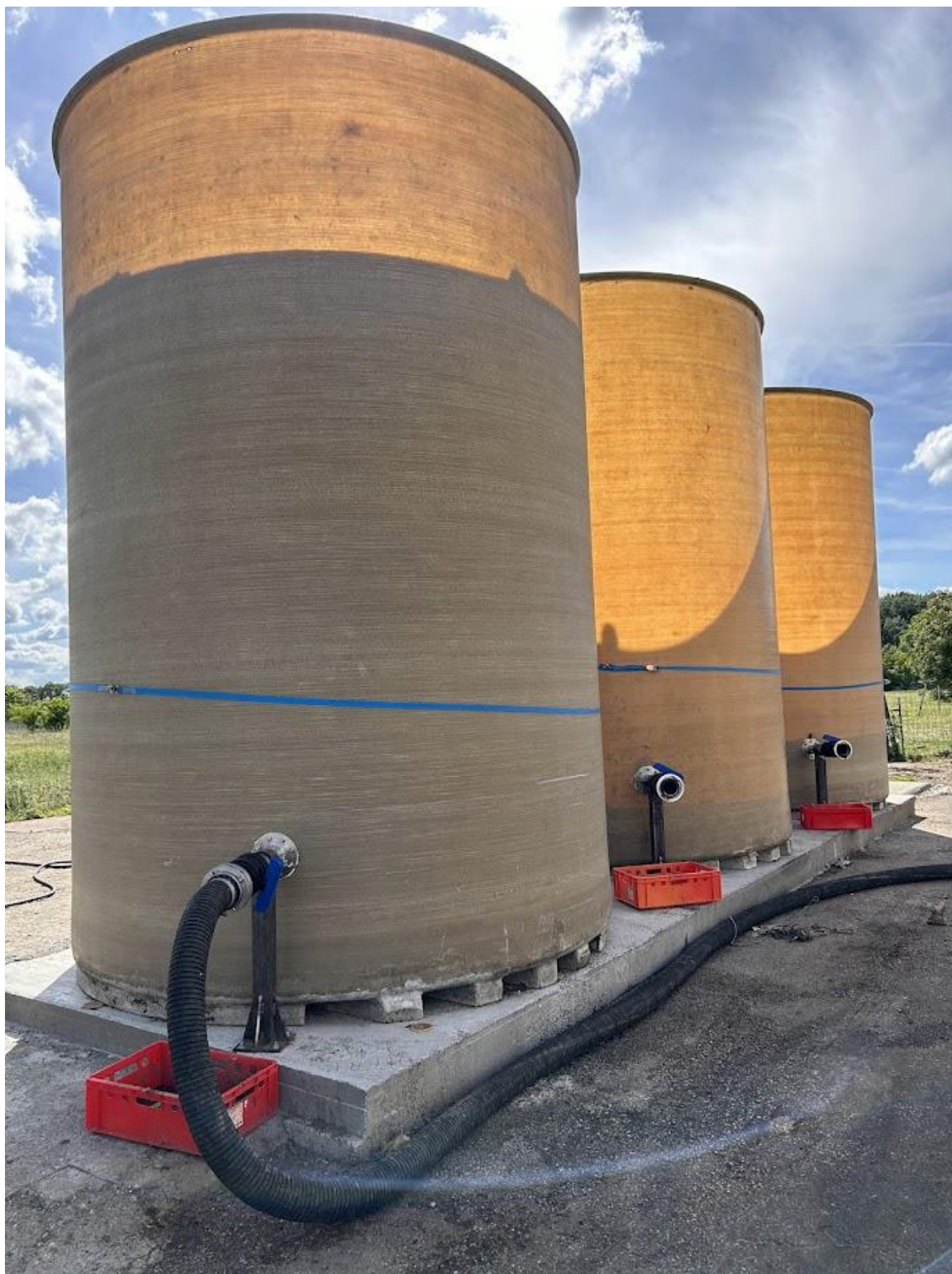
1. kép 3 db 30 m 3 föld feletti tartályok
