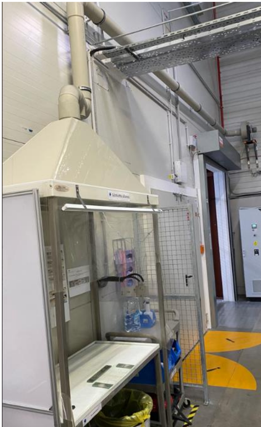
9. ábra: gőztisztító állomás, tetején az elmenő levegővel
