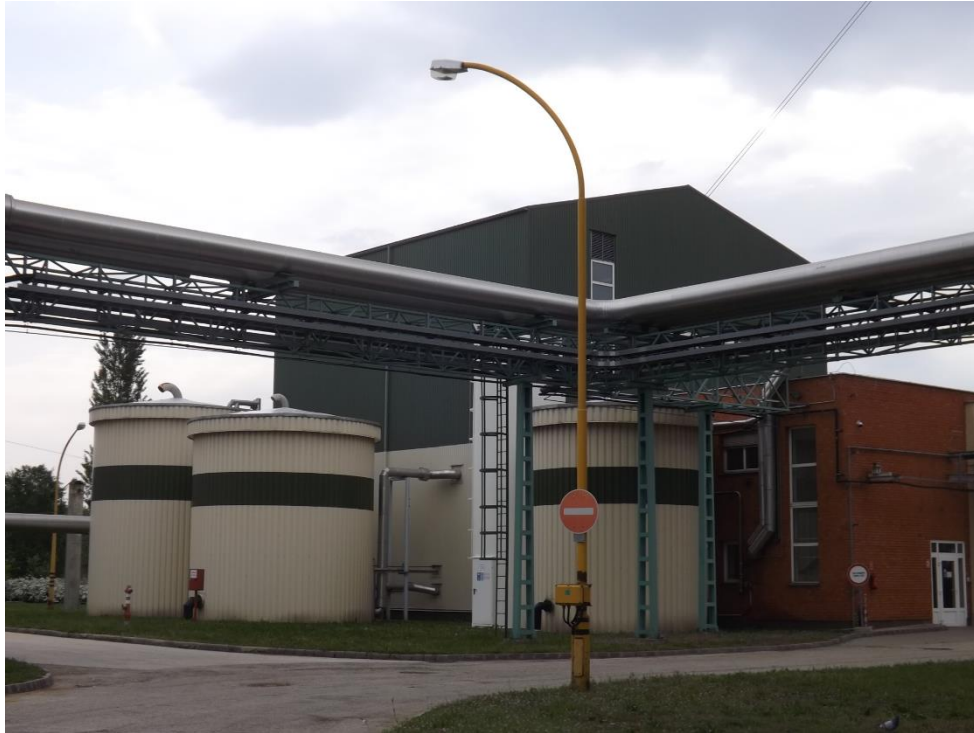
Vízkezelő üzem a kétszer-sóatlanvíz-, szűrt nyersvíz- és szűrő-mosóvíz tartályokkal
