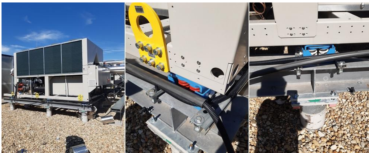
21. ábra Rezgés csillapítás a tetőn lévő hűtőgépnél
