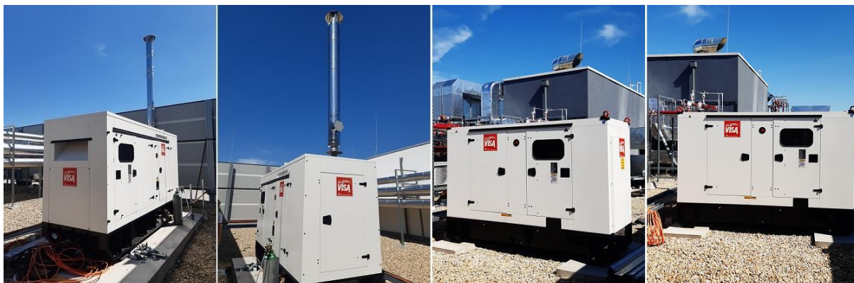
5. ábra épületek tetején lévő dízel aggregátorok szemléltetése
