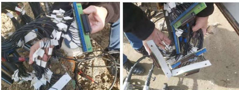
8.-9. kép: A 31. és 34. szekrények korrodált paneljei és vezetékei.
