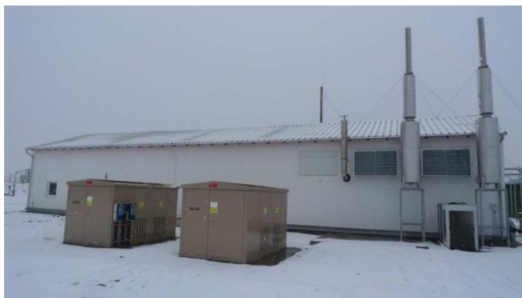
Á.14. ábra – Lemezházás transzformátorok
