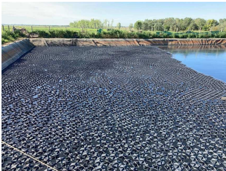
Á.10. ábra – Utótározó úszófedéllel
