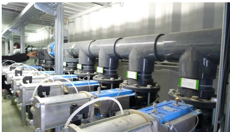
Á.8. ábra – Műszaki konténer késes elzáró szerelvények
