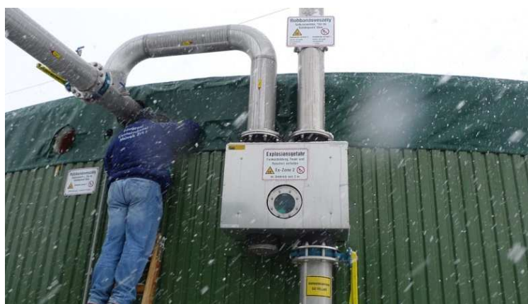
Á.9. ábra – Fermentorok biogáz biztonsági szelepe
