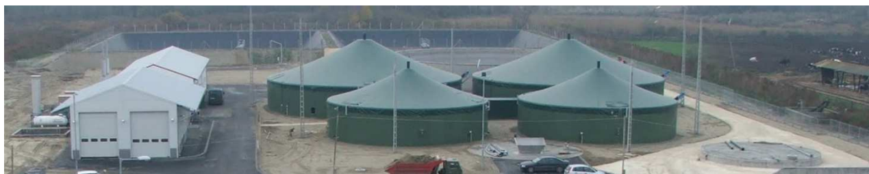
Á.7. ábra – Mezofil anaerob fermentorok
