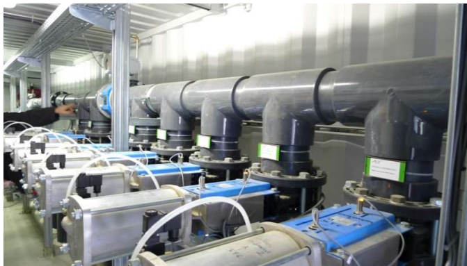
Műszaki konténer késes elzáró szerelvények
