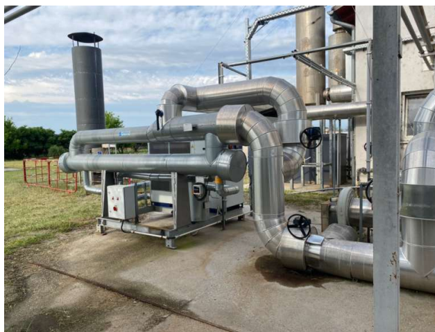
Biogáz hűtve szárító
