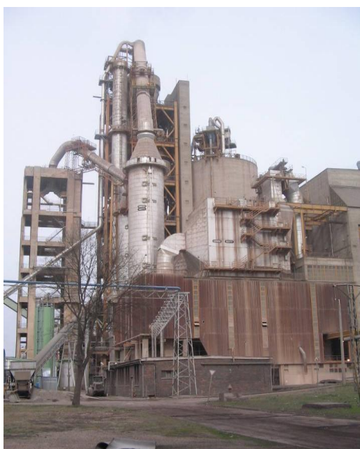
17. ábra: Kalcinátor, hőcserélő és a kemence kémény (P112)
