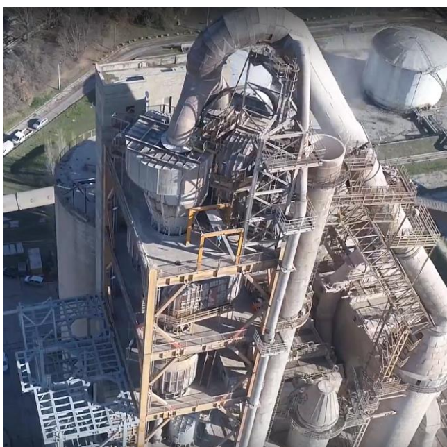
18. ábra: Hőcserélő ciklonok és a kemence kémény (P112)
