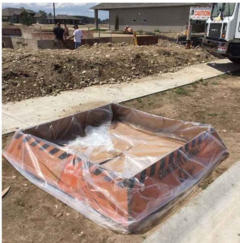
19. ábra: Betonzagy átmeneti tárolásának lehetséges megoldásai
